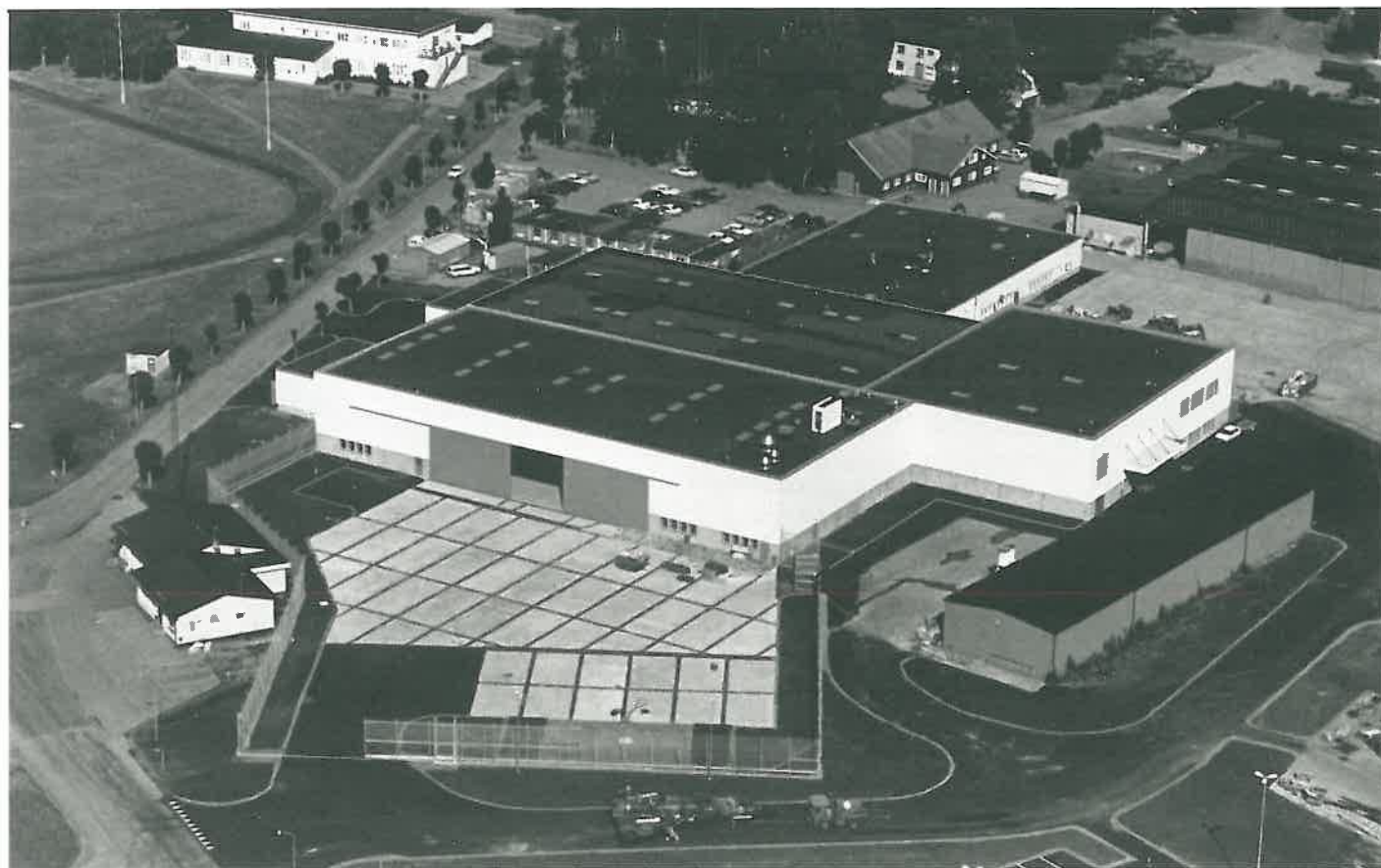
Vy över F 7 ombyggda flottiljverkstad.
